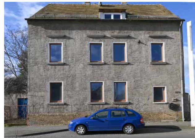
Das Haus des ehemaligen Milchladens; rechts war die Ladentür. Die Stufe ist noch da. Foto: Matthias Hildebrand
